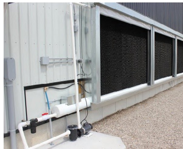
Système de refroidissement par évaporation – tapis humide.
